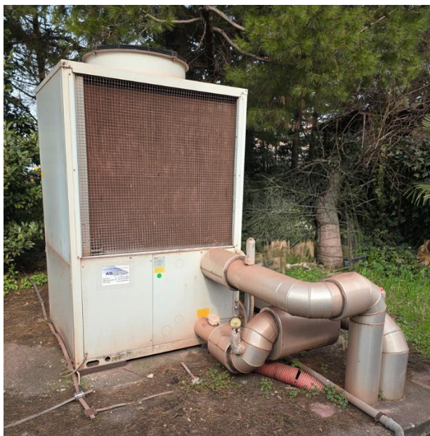
Slika 1: Obstoječa nedelujoča toplotna črpalka
